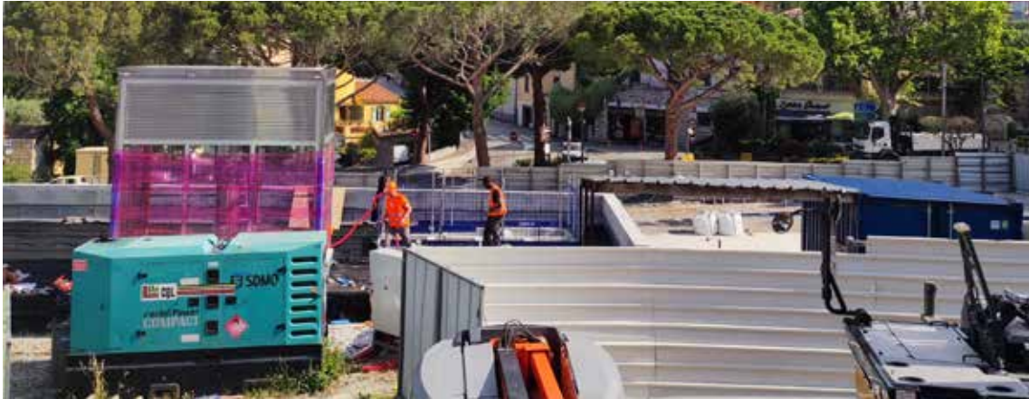
Le chantier du parking avance à grands pas... Ici, le retrait symbolique de la grue. Livraison prévue en juillet 2023
