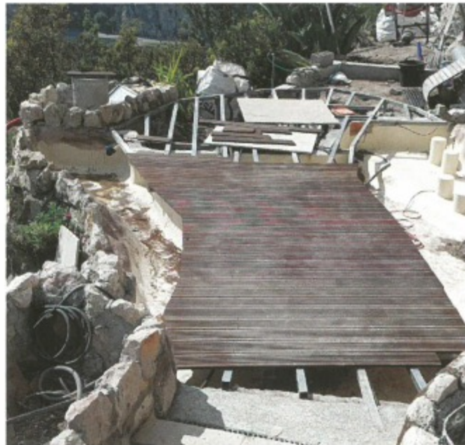
LA RÉFECTION DE LA TERRASSE
